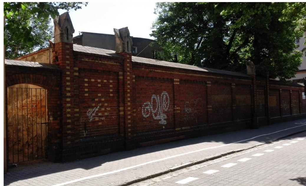
Fot. ul. Żeromskiego – Budowlana – rok 2019
